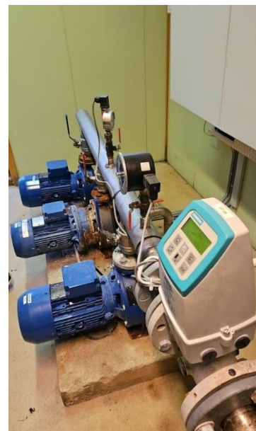
Figur 7: Pumper og vannmengdemåler ut fra stasjon B (Foto: Rambøll, 14.11.2024)
