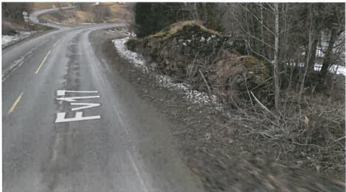
Fjell i dagen som vil måtte sprenges bort.
